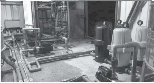
復興鄉義盛國小淨水設備
