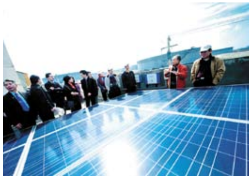
▲本次配合獎助金資助的太陽能發電設備
