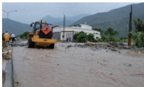
蘇拉颱風登陸花蓮秀林鄉，暴雨沖刷中央山脈東側邊坡，造成位於山脈東側的台9線順安路段嚴重積水。（中央社提供）
